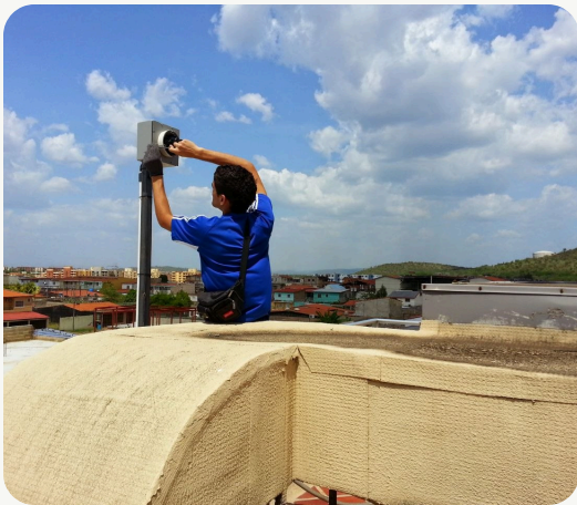
Instalación de cámara exterior
