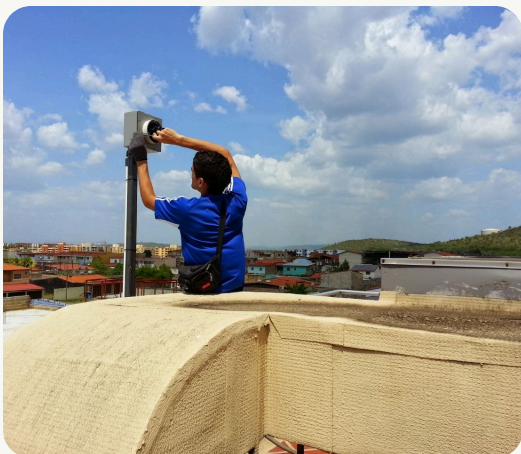
Instalación de cámara exterior
